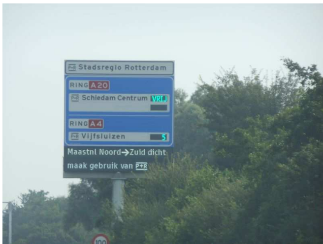
Figuur 19: Toepassing van een P+R paneel bij Rotterdam (bron: autosnelwegen.net)
