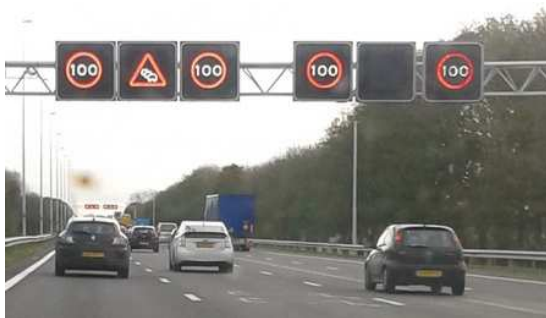
Figuur 11: Matrixsignaalgevers met maximumsnelheid en argumentatieborden (bron: wegenforum.nl)
